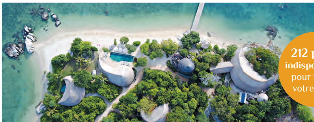
Photo de couverture : Cempedak Private Island, Éco-resort & Spa, niché dans une forêt préservée sur une île privée d'Indonésie, fonctionnant en quasi-autosuffisance énergétique.
